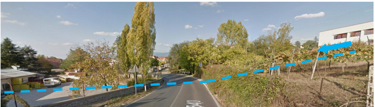
Figura 44 - Attraversamento tombato lungo SP540, Levene. In blu il tracciato del corso d'acqua così come è individuato nel reticolo di gestione di cui alla LR 79/2012.
