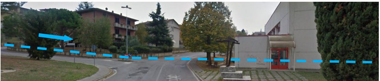
Figura 43 - Attraversamento tombato lungo Via Palmiro Togliatti, Levene. In blu il tracciato del corso d'acqua così come è individuato nel reticolo di gestione di cui alla LR 79/2012 aggiornato con DCRT 9/2015.
